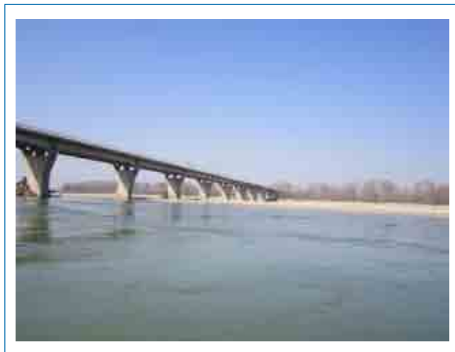
Ponte sul fiume Po a Isola S. Antonio (AL )
