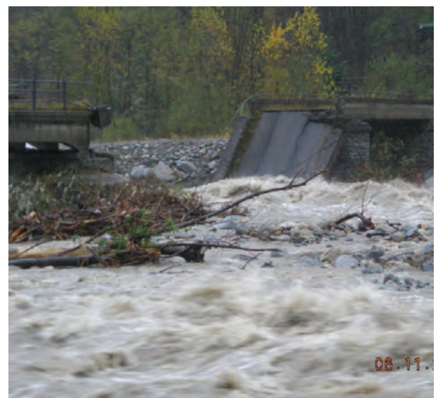
Il crollo del ponte del Bertenga a Torre Pellice
