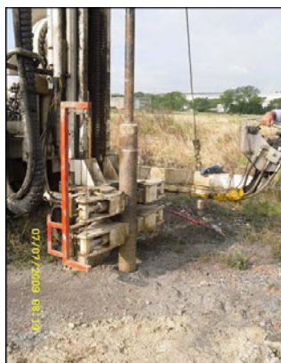
Metodo di Perforazione a carotaggio del suolo Foto: Arpa Piemonte
