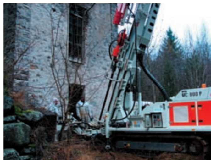
Macugnaga, fraz. Pestarena: operazioni di sondaggio per prelievo campioni
