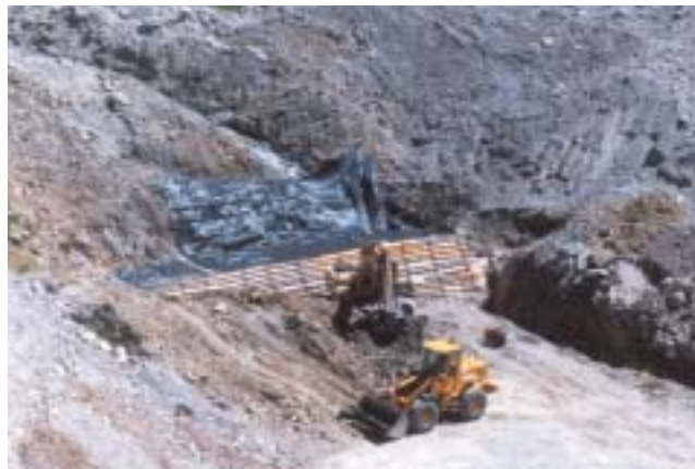
Figura 6. 31 – Lavori di costruzione del primo salto di fondo verso monte
