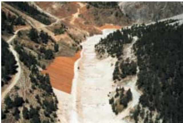
Figura 6. 30 – Bacino di deposito costituito da 15 salti di fondo, realizzato in territorio francese
