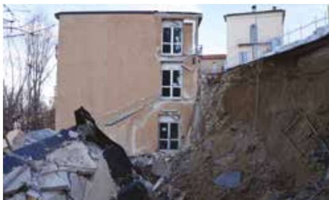
Mondovì. Dettaglio frana del 29 dicembre 2017
